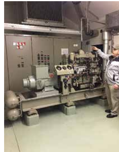
Der Notstromgenerator.
